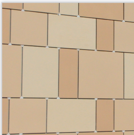
Płyta MgO (magnezowo-włóknowa) klejona na elewacji do podłoża ocieplonego styropianem w systemie ETICS
