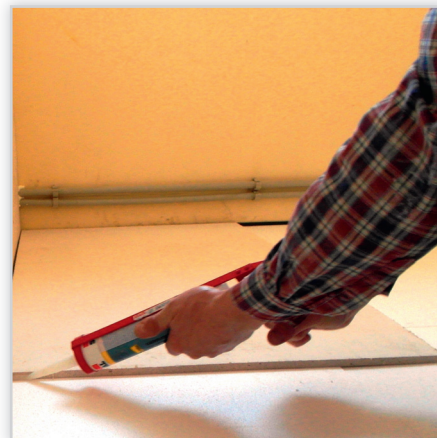
Suchy jastrych – płyta MgO magnezowo-włóknowa zastosowana jako wytrzymały podkład podłogowy. Płyta MgO może być stosowana w obszarach o wysokim natężeniu ruchu np. w korytarzach, jak również przy zastosowaniu izolacji termicznej np. w ocieplaniu podłóg.
